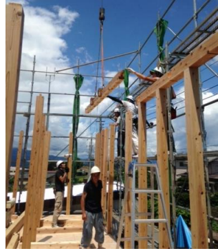
レッカーで吊っています
