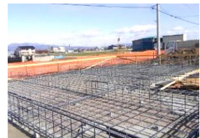
鉄筋の組み上がり風景
