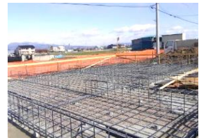
鉄筋の組み上がり風景
