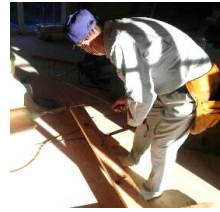
天井の材料加工中!!
