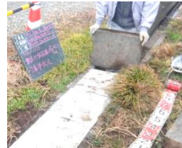
開発工事中です
