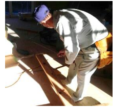
天井の材料加工中!!
