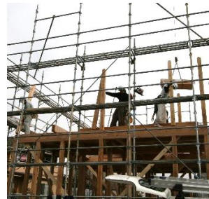
上棟式に向けて、棟を 上げています。
