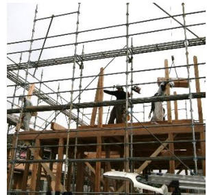
上棟式に向けて、棟を 上げています。
