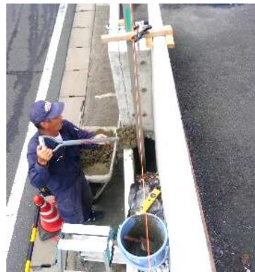
職人さんが工夫しての柱の仮固定
