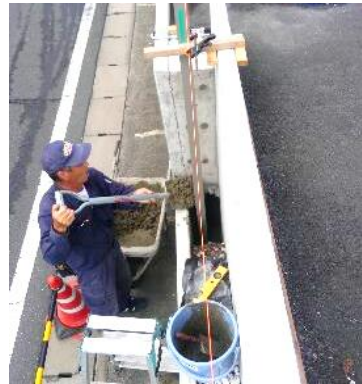
職人さんが工夫しての柱の仮固定
