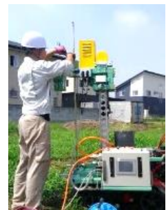
地耐力を機械で測定中
