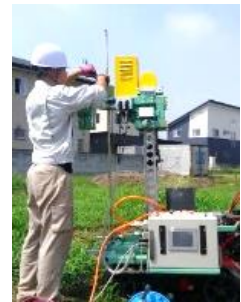
地耐力を機械で測定中
