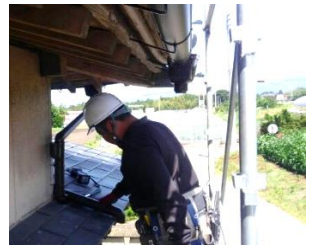
雨樋を交換しています
