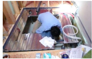
ユニットバスの配管を繋いでいます
