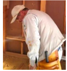
自分と大工さんで窓の設置高さを検討中
