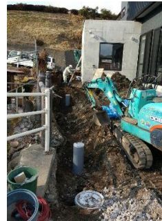
重機で掘削中
