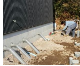
外部配管を加工中
