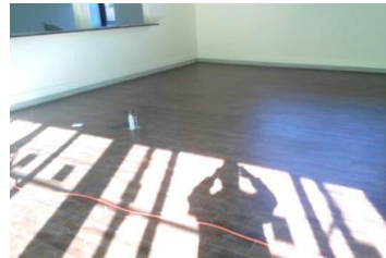
店舗床の状況
