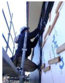
外壁工事：窓の部分は細かい作業なので、奮闘中。
