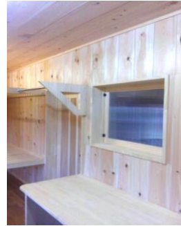
無垢板の壁天井
