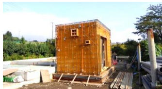
K様邸、型枠工事 第一工程完了
