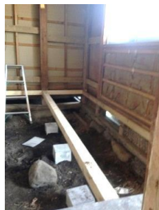
新しい床下地を作っています
