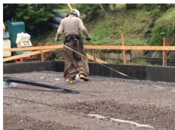
鉄筋に墨出しという作業を している木暮さんです。
