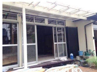
改修前の外からの写真
