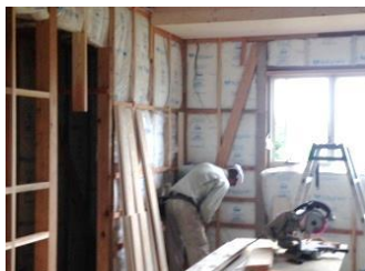
断熱改修工事
