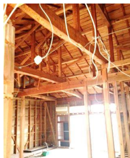
解体した時の状態
