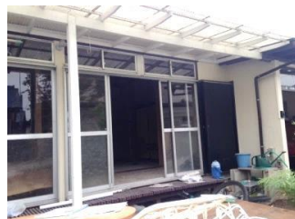
改修前の外からの写真
