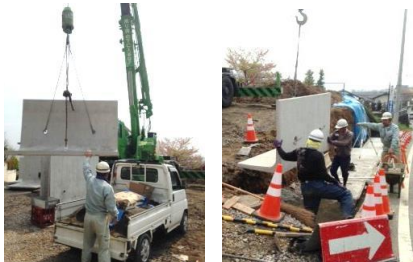
擁壁工事中です
