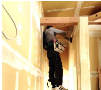
内装工事の下地工事中です
