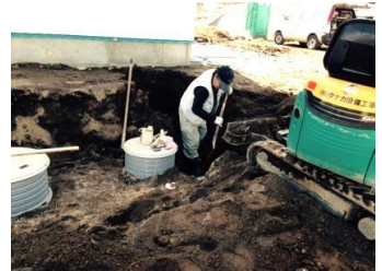
浄化槽設置工事
