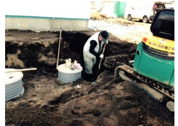
浄化槽設置工事
