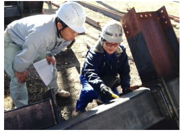
鉄骨材の溶接部分の 超音波検査
