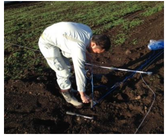
農作業の様ですが、(笑) 雨上がりの地縄張りです
